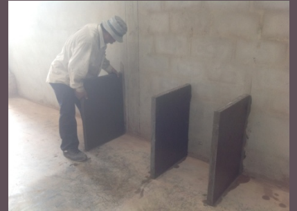
3 ยกแผ่นขาที่ป้ายปูนกวาดแล้วเข้าติดตั้ง
