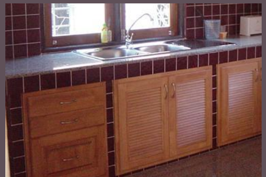
11 ปูกระเบื้องตกแต่งและติดตั้งอุปกรณ์ต่างๆ เช่น ทอปหินแกรนิต ซิงค์ และชุดบานซิงค์
