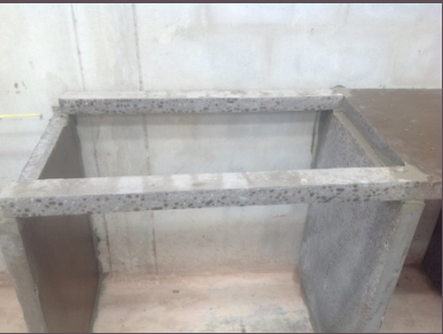
7 ลักษณะของหลุมซิงค์ที่ประกอบขึ้นโดยใช้ตัวคาน (lintel)
