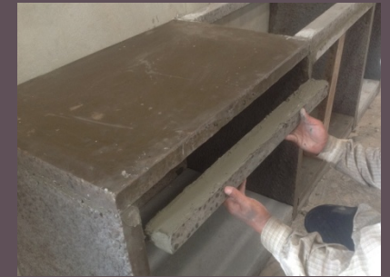
9 ติดคานตัวล่างเข้ากับแผ่นตัวบนด้วยปูนกวาด
