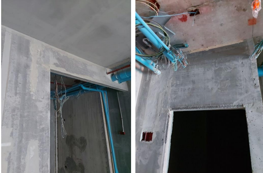
ลักษณะของผนังหลังจากทำความสะอาดและขัดแต่งผิวให้เรียบ
