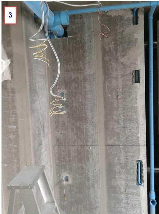
ลักษณะของท่อที่ใส่เข้าไปในรู hollow ผนังแล้ว
