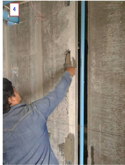
ปิดทับรอยบากด้วยปูนมอร์ตาร์เพื่อล็อกท่อ ป้องกันการสับของท่อ
